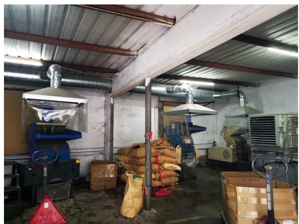
破碎废气收集措施（C2车间）
